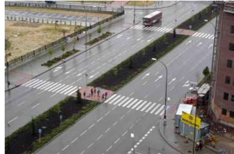
Cruce peatonal de longitud excesiva
