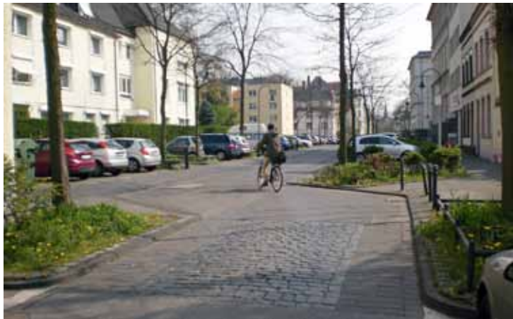
Los cambios en el pavimento y el zig-zag moderan la velocidad. Berlín
