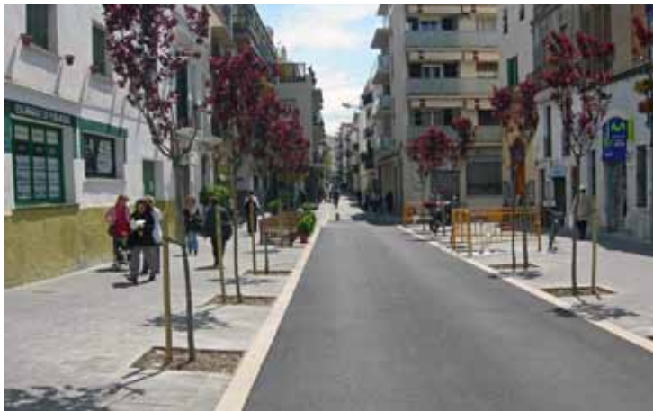
Ampliación de aceras y plantación de arbolado. Sitges
