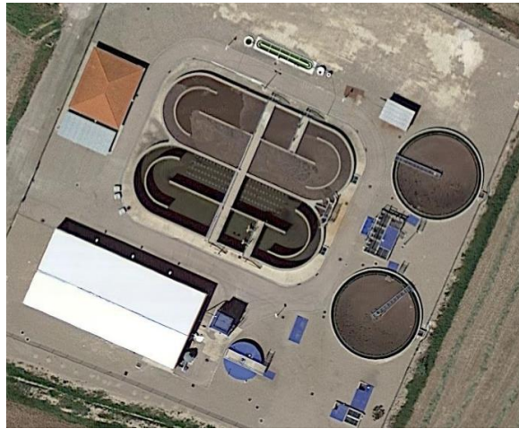
Figura 3. Visión aérea de la EDAR de Villanueva del Gallego (Zaragoza).
