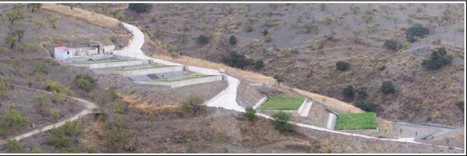
Etapa Primaria (Rellen de sustratos balsas - Canalizaciones exteriores)
