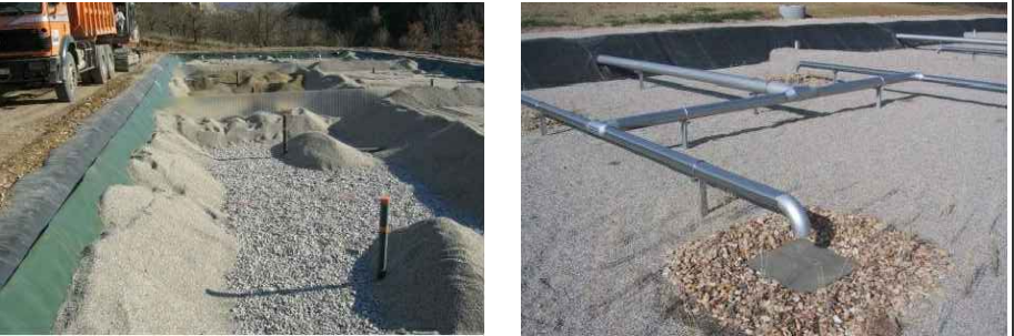
Etapa Secundaria (Geomembrana y geotextil de protección - Rampa de aportación)
