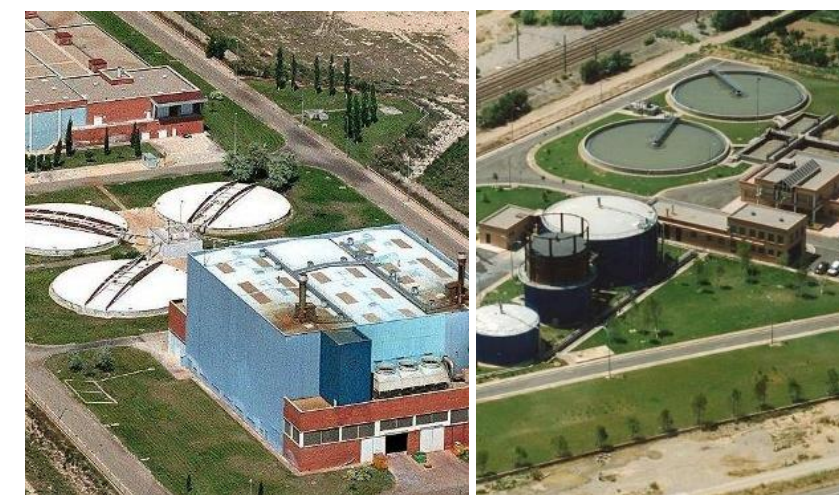
Figura 2. Instalaciones de depuración existentes en la ciudad de Zaragoza.
