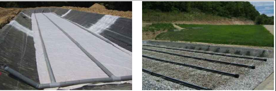
Etapa Secundaria (Geomembrana y geotextil de protección - Rampa de aportación)
