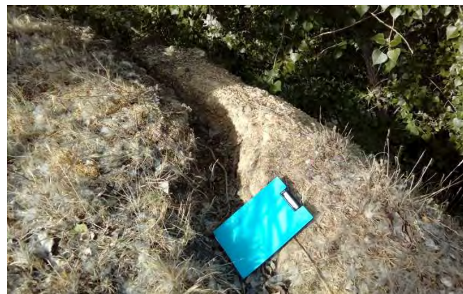
Grieta en cabecera, con abertura inicial de unos 25 cm
