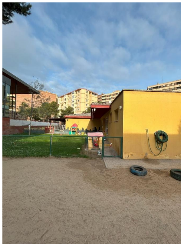
Imagen 5: Foto de la zona de la cubierta plana existente con el porche
