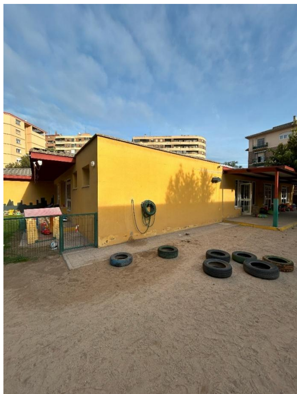
Imagen 4: Foto de la zona de la cubierta plana existente
