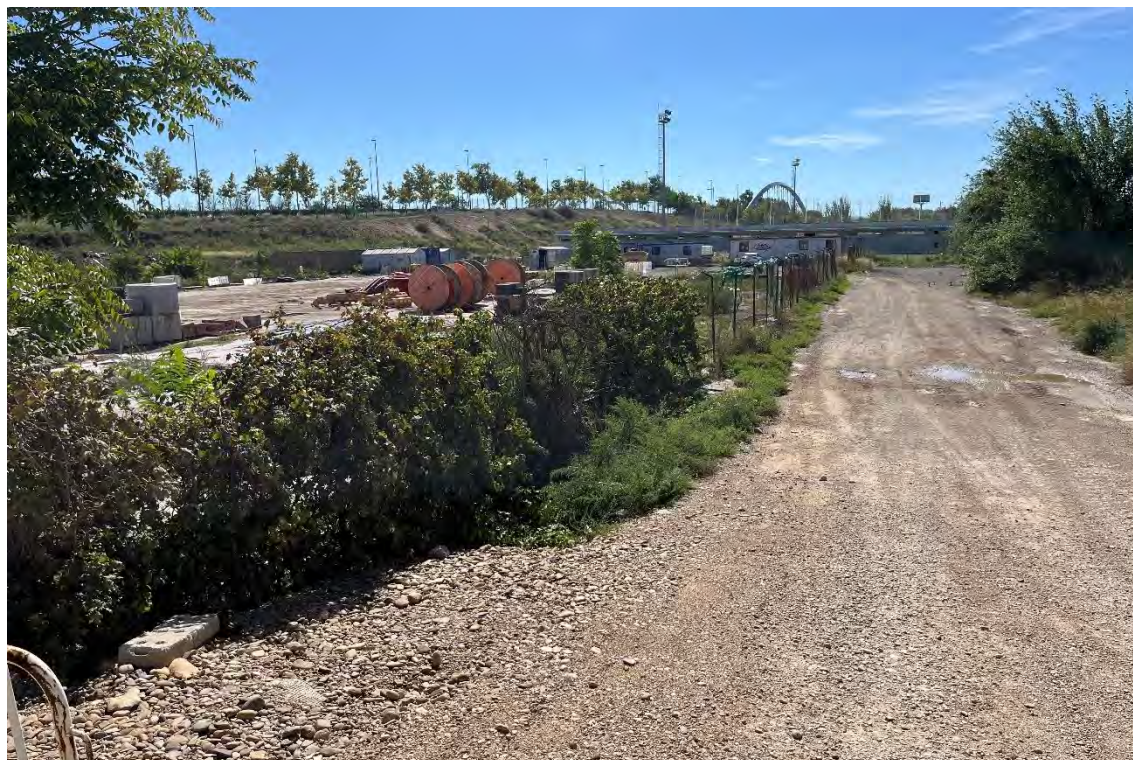
Espacio de la parcela para nuevo campo de fútbol 11. Vista desde camino de tierra actual hacia los vestuarios de la primera fase.
