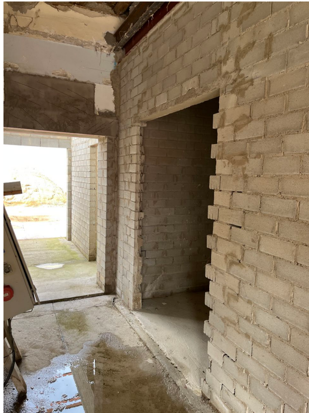
Vista interior hueco ascensor
