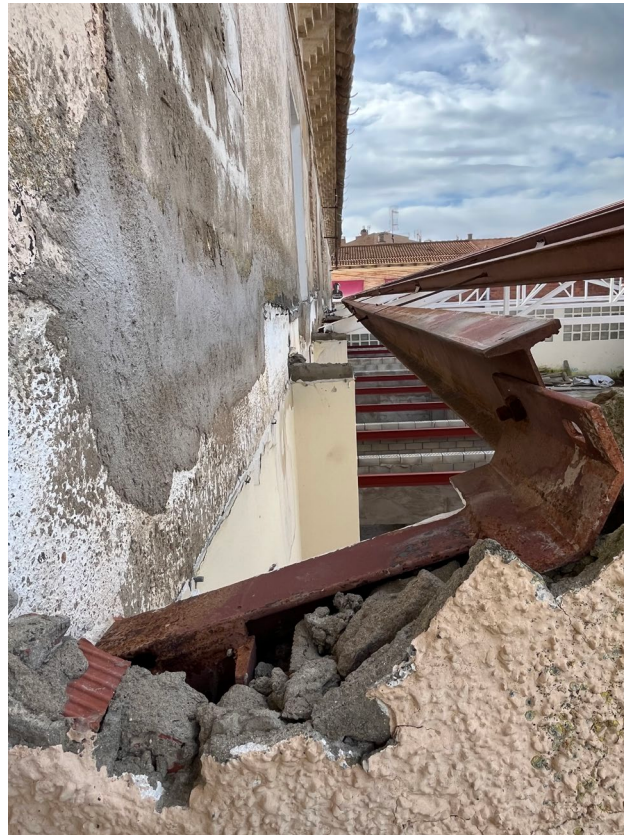
Vista detalle cubierta pabellón encuentro con fachada Centro Cívico
