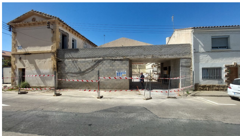
Fachada C/ San Roque
