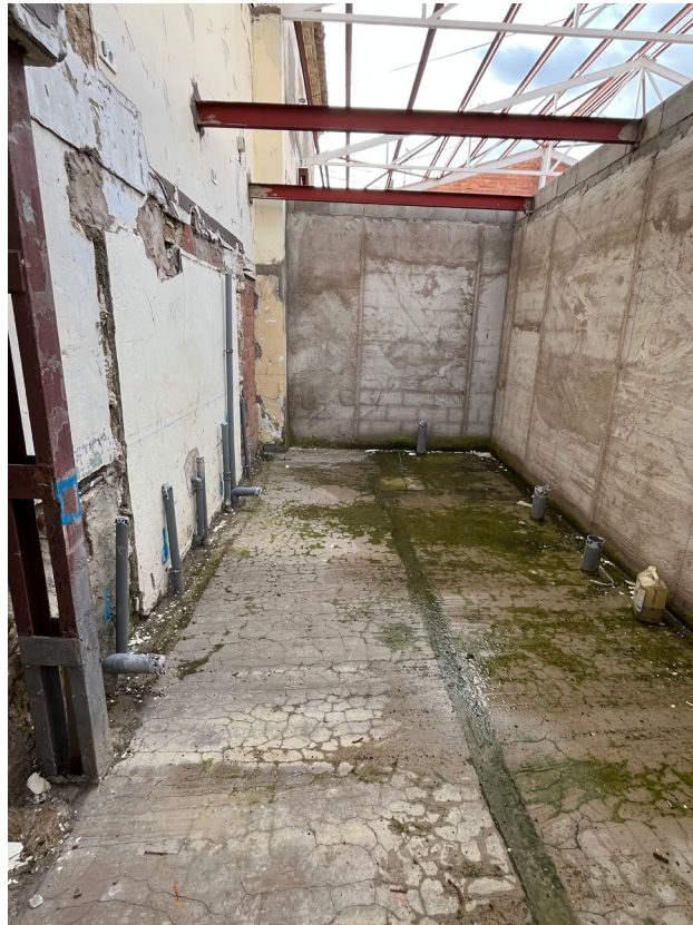
Vista interior zona aseos
