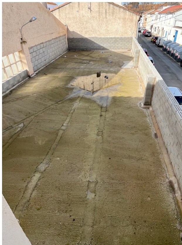
Vista forjado terraza instalaciones
