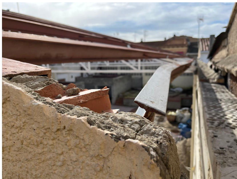
Vista detalle correa cubierta pabellón
