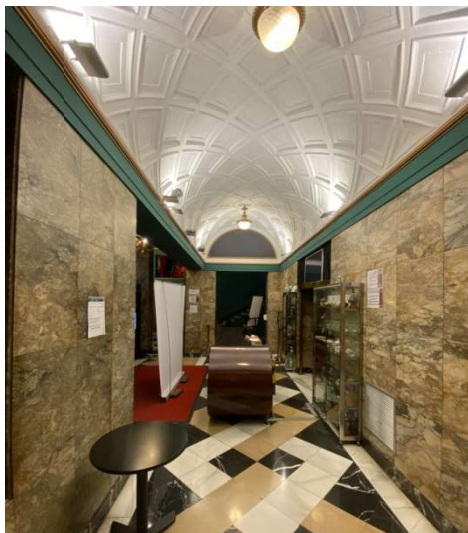
Bóveda en Vestíbulo Principal, estado actual
