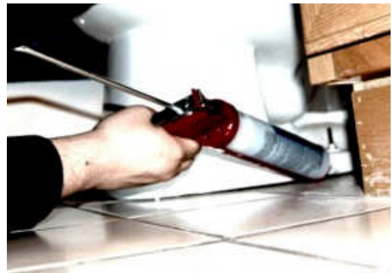
Selle con silicona grietas y rendijas
