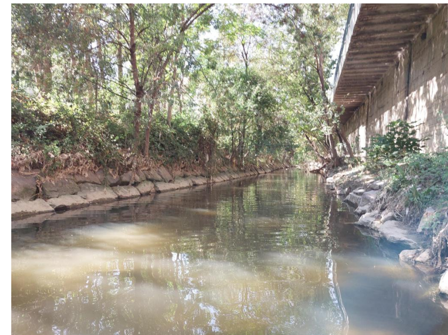
Figura 15. Cauce con estructura longitudinal simplificada (tabla) aguas arriba del puente de Jorge Cocci.
