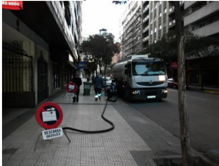
Ilustración 8.31. Descarga de Gasóleo que se realiza 6 veces al año.
