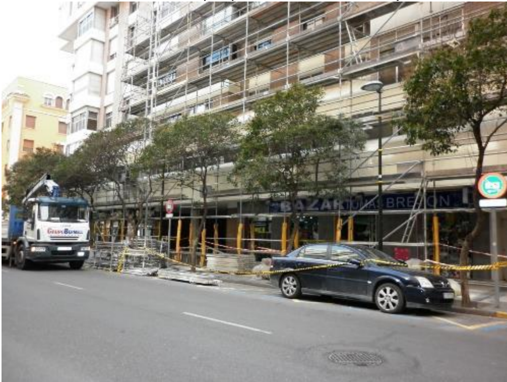
Ilustración 8.37. Zona de C/D número 6 ocupada por obras durante la mitad de la jornada de toma de datos
