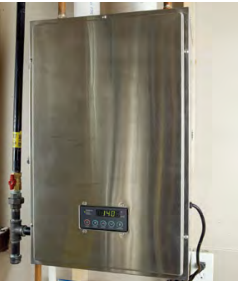
一个民用冷凝式混合动力电热水器。这一技术按需制造热水,比传统热水器更节能。© BanksPhotos/iStock
