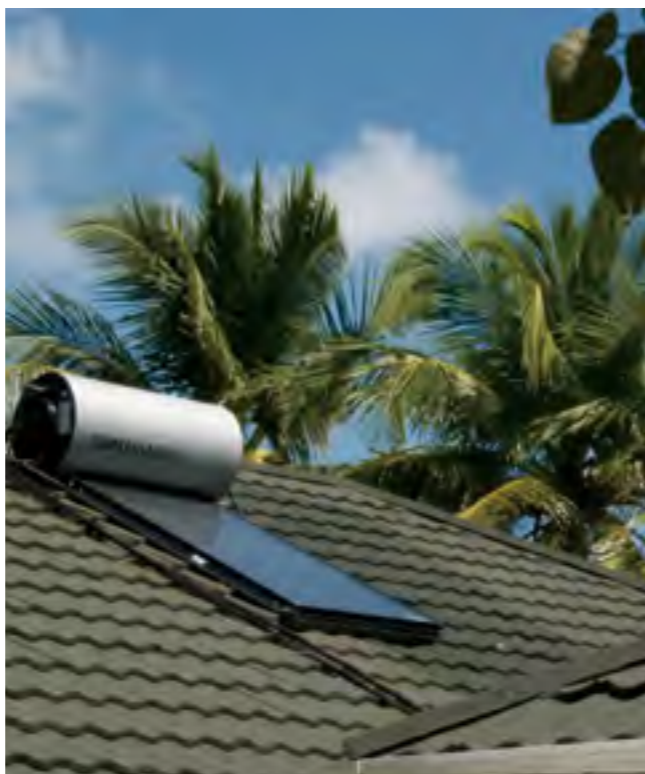
在满足家用能源需求方面,太阳能热水器已经成为了越来越普遍和具有成本有效性的方式。© Igor Bystrov
