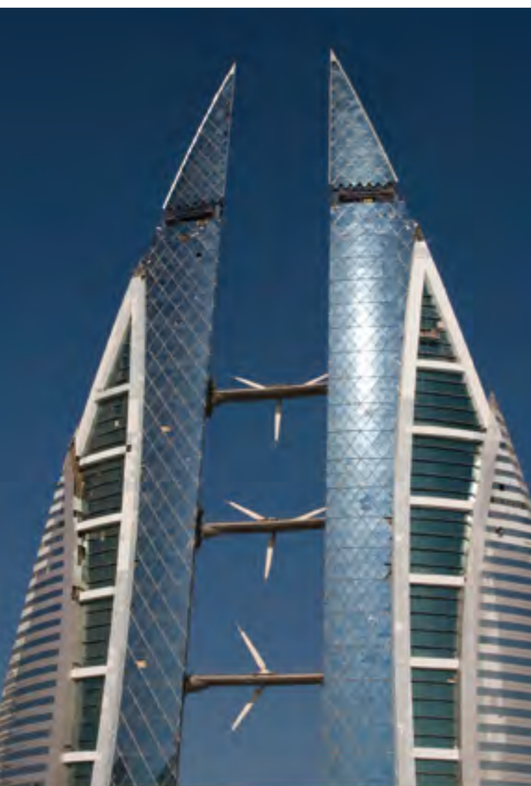
安装有三个一体式风力涡轮机,巴林世界贸易中心拥有世界上最先进的摩天大楼能源回收系统。© Klaas Lingbeek- van Kranen
