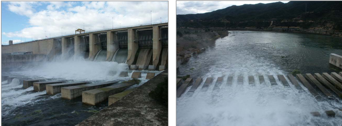
Figura 3-1. Presa de Riba-roja (izquierda) y tramo de río aguas abajo (derecha) que se corresponde con la cola del embalse de Flix.
