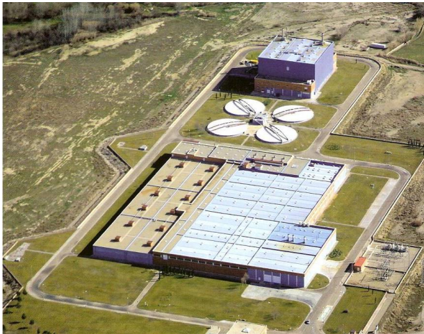
Fig.1 El sistema de cerramiento y desodorización de la Depuradora de La Cartuja, la hace muy diferente de cualquier EDAR convencional
