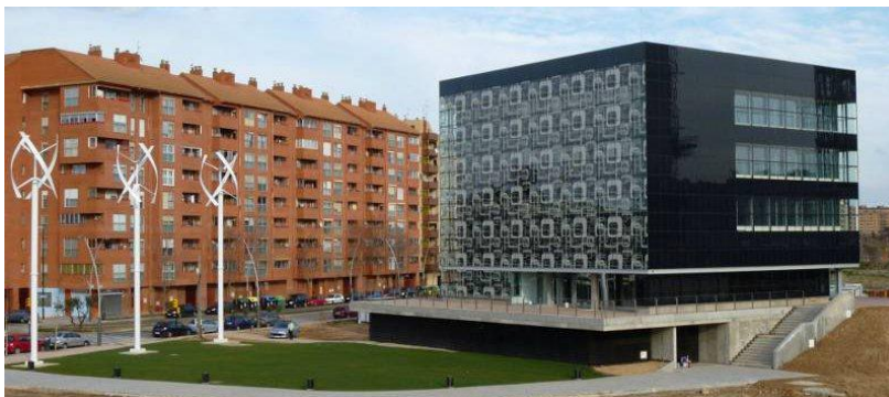
Fig. 1 Centro de Incubación Empresarial. Edificio “Cero Emisiones”
