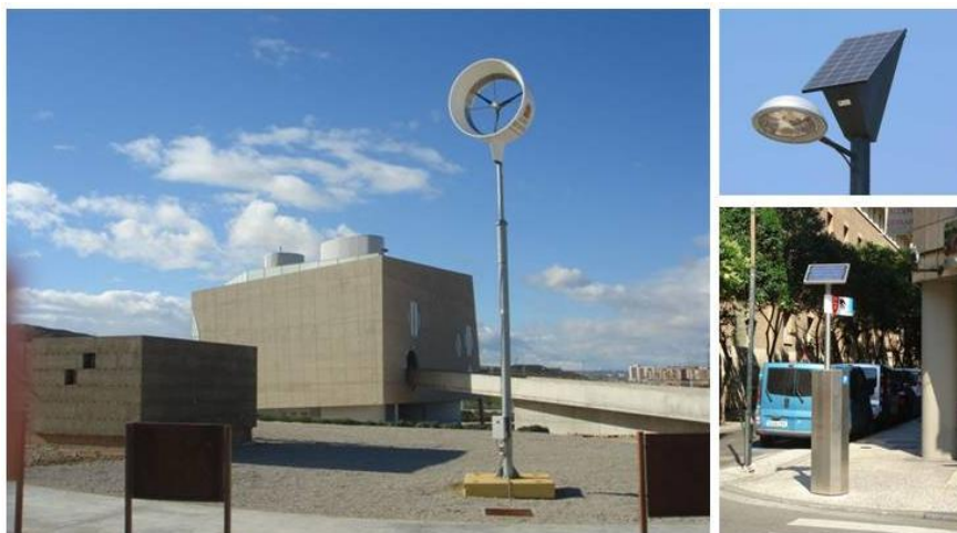
Fig 3. Actuaciones públicas de aplicación de energías renovables. Centro de Urbanismo Sostenible, farolas y parquímetros fotovoltaicos
