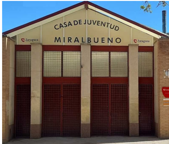
FOTO ACCESO / SALIDA 4
