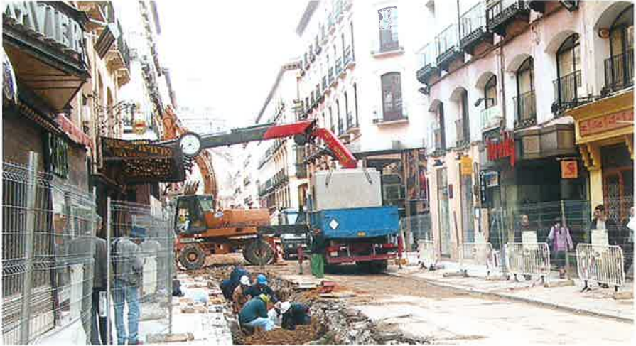
Vista de la calle Alfonso durante los trabajos de remodelación.
