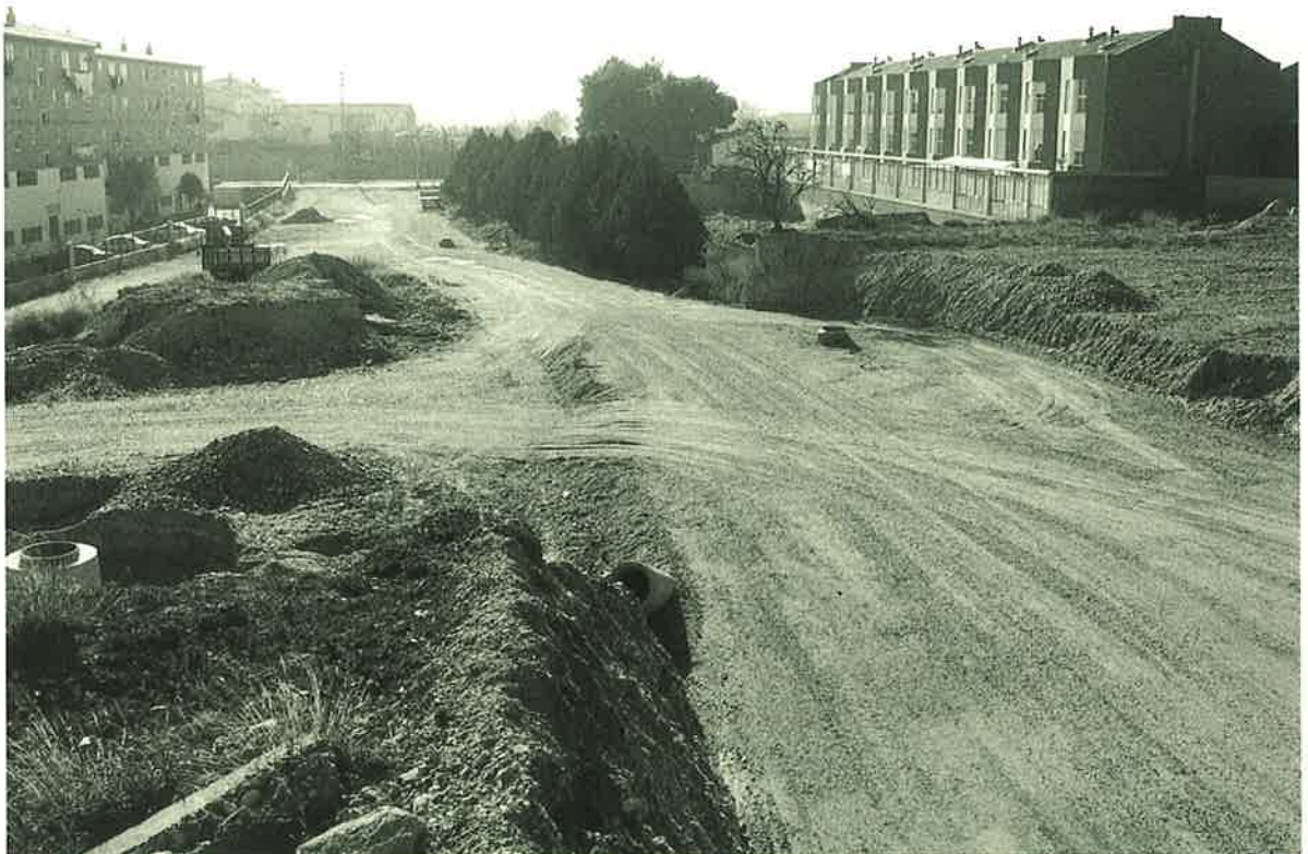
Obras del nuevo acceso en Miralbueno
