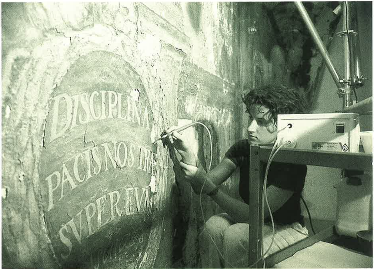
Trabajos de restauración en la iglesia de Santo Tomás de Villanueva
