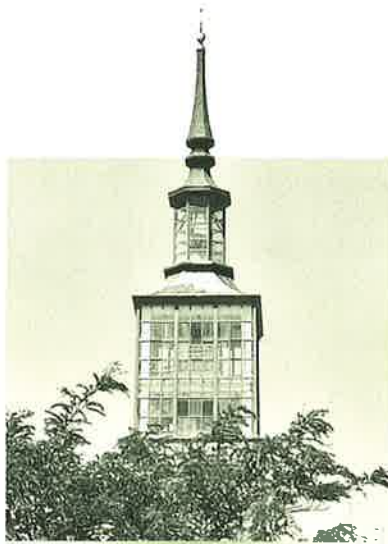
Detalle de la torre de la antigua Feria de Muestras
