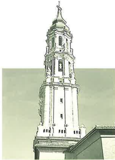
Detalle de la torre de la catedral de la Seo
