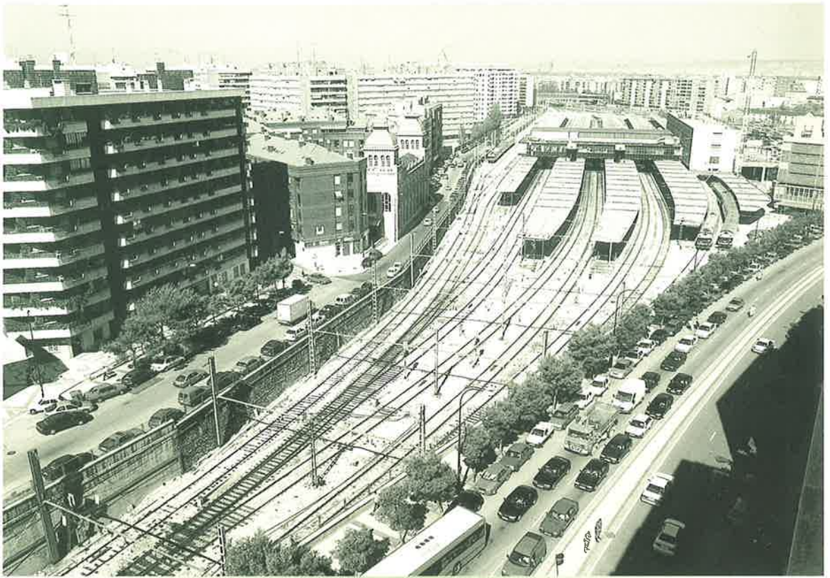
Estación de El Portillo
