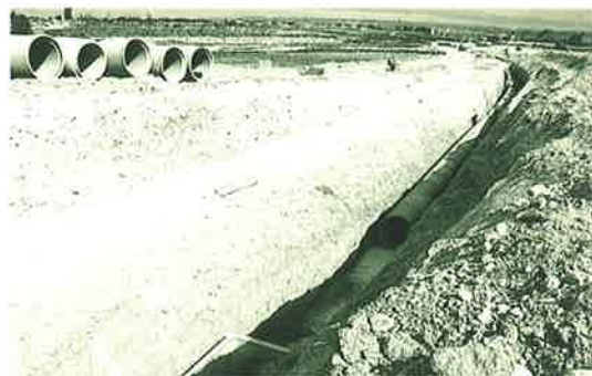
Obras de la Ronda Oliver
