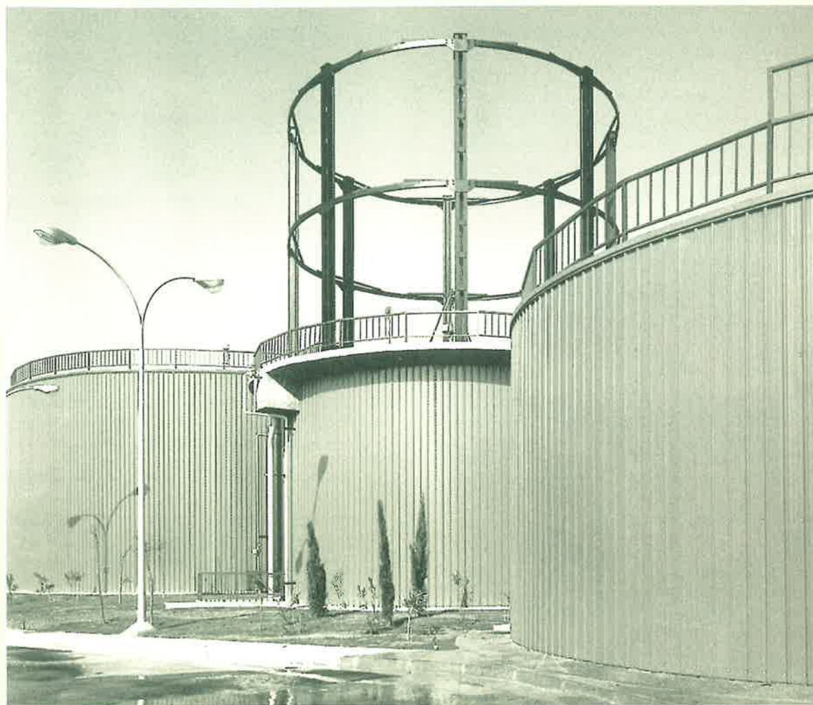
Depuradora de aguas residuales de la Almozara
