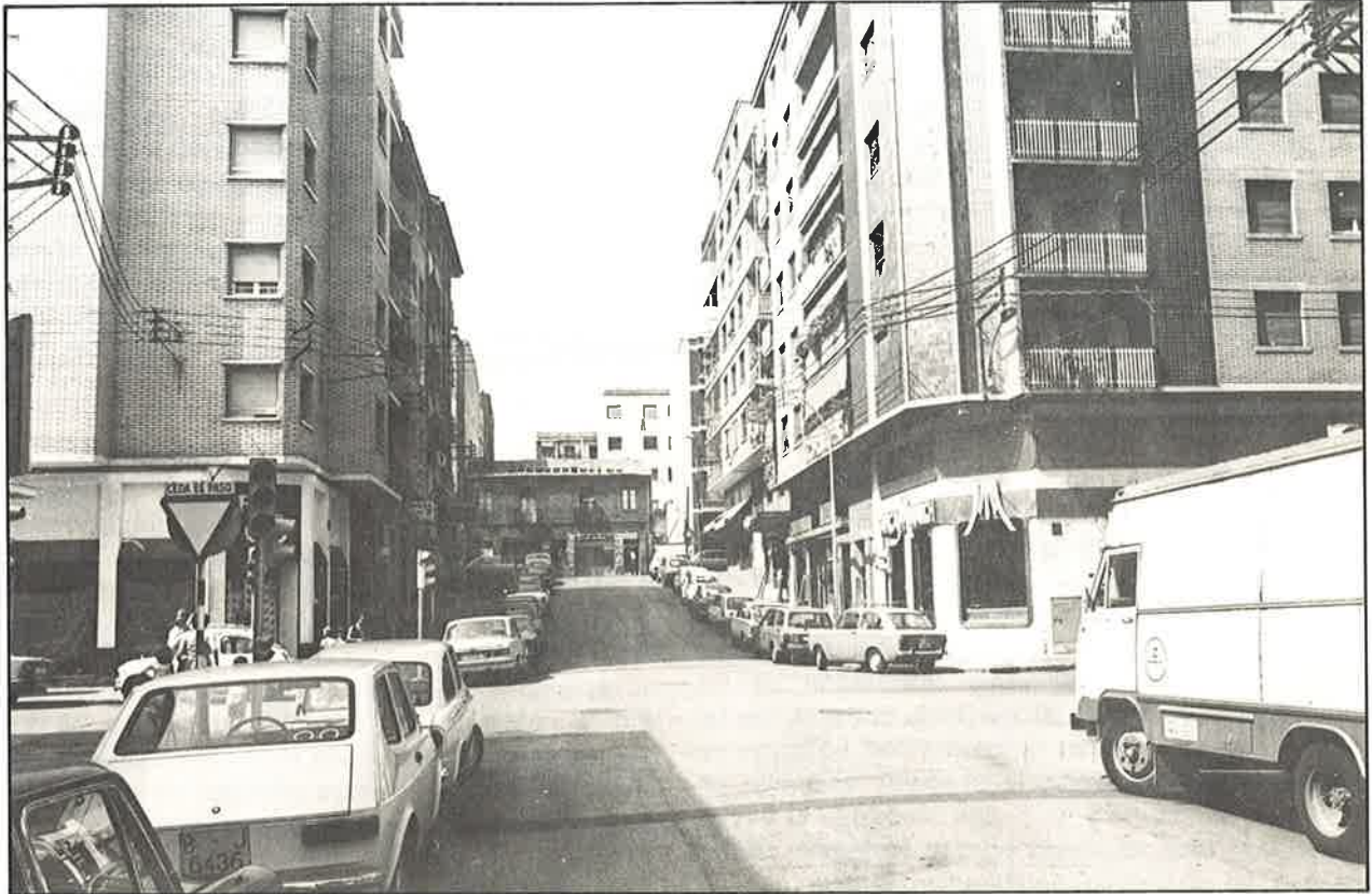
La apertura de nuevas vías ha representado la destrucción de las parcelaciones tradicionales. En primer término, escarpe de la terraza.
