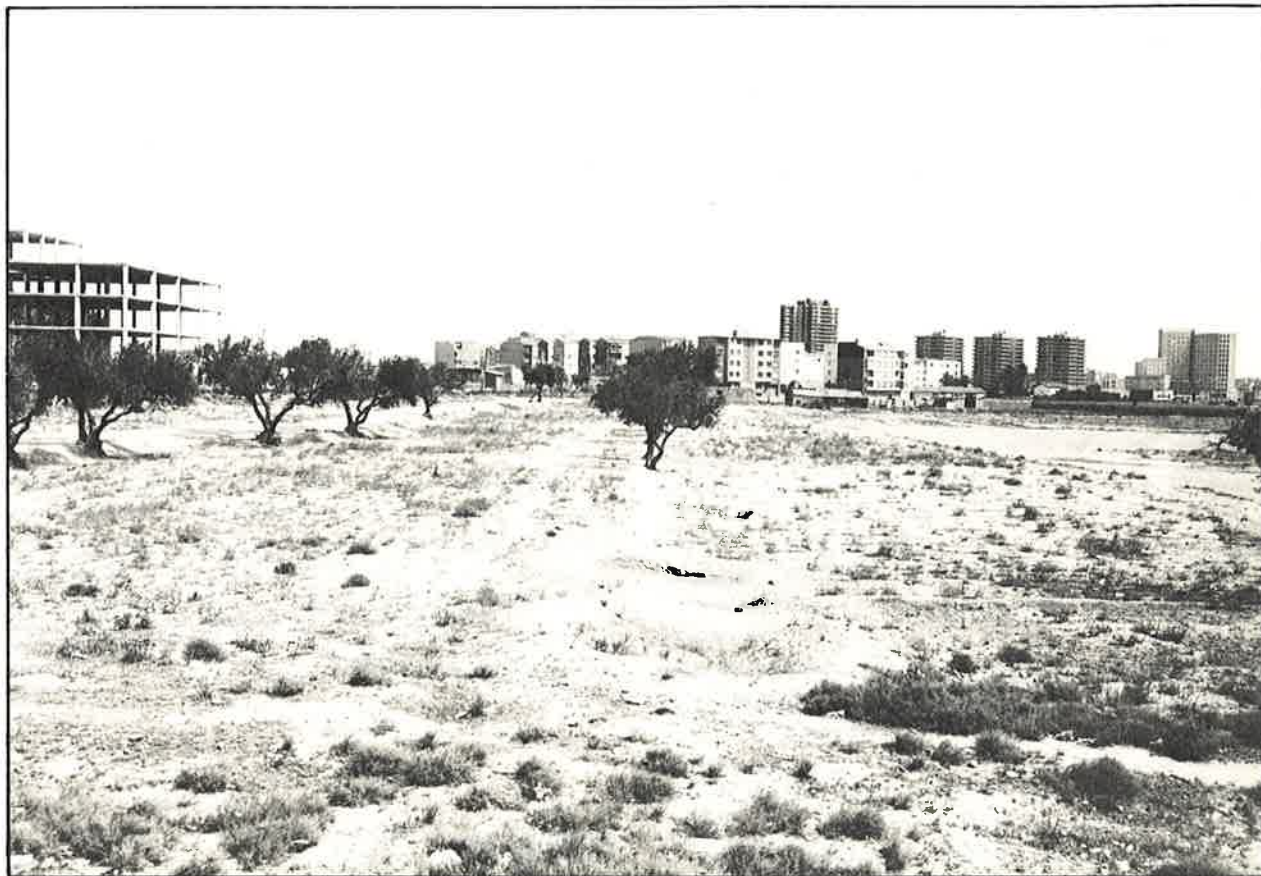
En primer término, los olivares de la Bozada, improvisados campos de fútbol, junto a la estructura del futuro Hospital Oncológico. Al fondo, las torres de Universitas.
