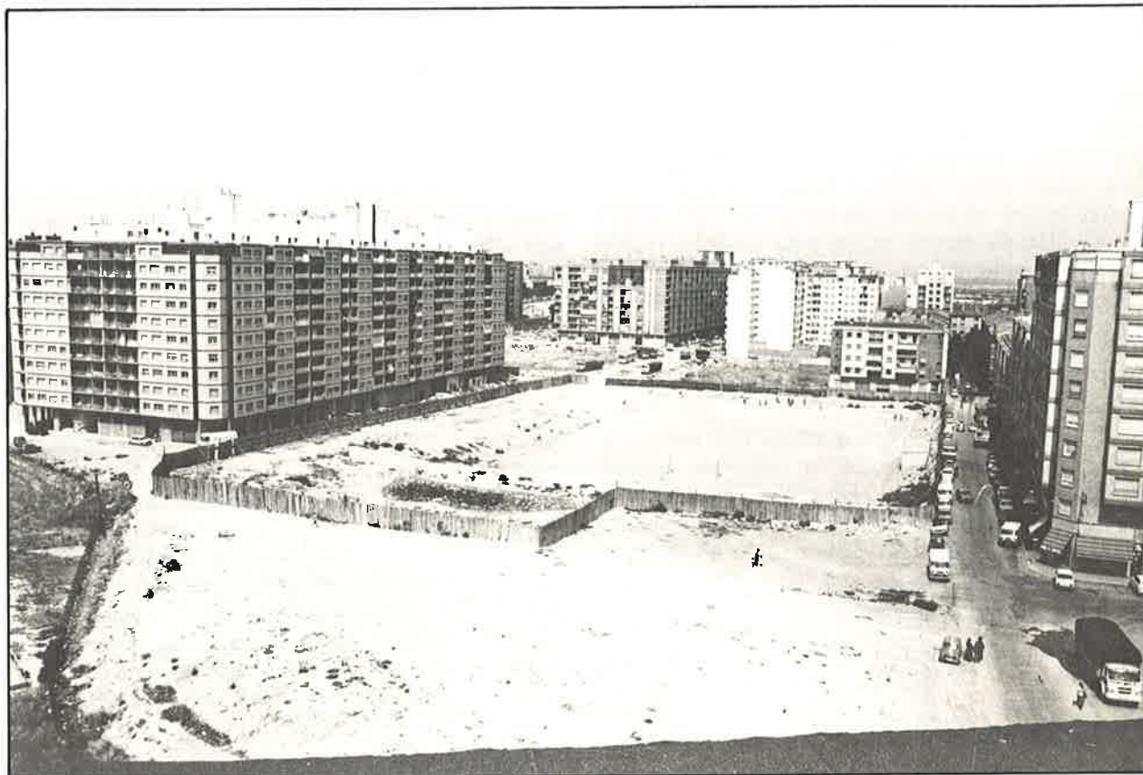
Las nuevas edificaciones de planta baja y diez más, con elevadas densidades, «cercan» el espacio de las antiguas fábricas.
