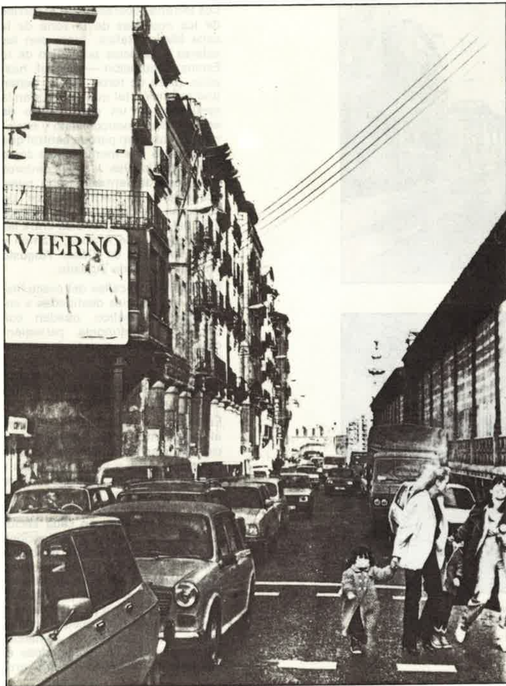
Plaza de Lanuza. Estado actual.
