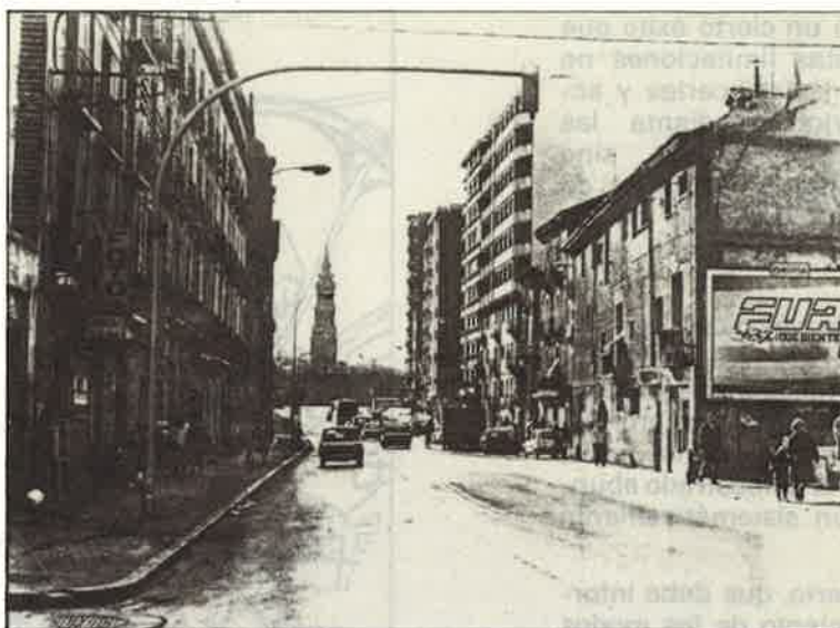
Calle Sobrarbe. Estado actual.
