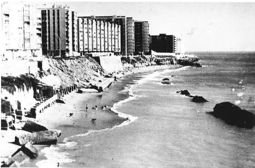
4. El «frente del vendaval» y la Playa de Santa María del Mar. El avance del oleaje ha destruido y sobrepasado las defensas del siglo XVIII.
