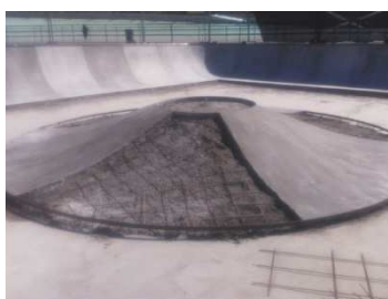
Hormig. HA-25 pulido manual, fábricas de bloques, aplacados, solados y drenaje metálica
