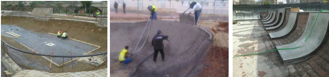
Excavación, perfiles metálicos, gunitado de hormigón y saneamiento.
