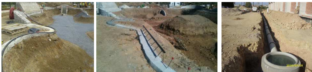
Excavación, colocación de coping y saneamiento.
