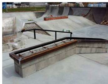
Hormig. HA-25 pulido manual, fábricas de bloques, aplacados, solados y drenaje metálica
