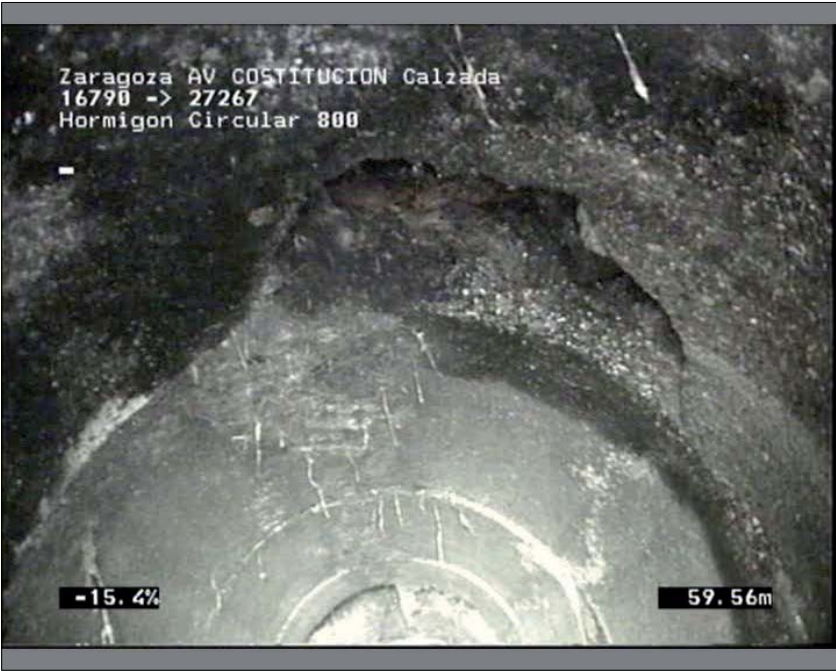
Foto: 1_1_7_A.JPG 59,56m, Acometida desde 12 hasta 03 horas / Acometida Lado Dcho. Entronque defectuoso de la acometida con la red general. Posible infiltración de agua por el entronque defectuoso de la acometida
