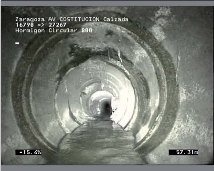
Foto: 1_1_6_A.jpg 58,32m, Comentario / Humedad en la junta de la tubería. Posible junta abierta.
