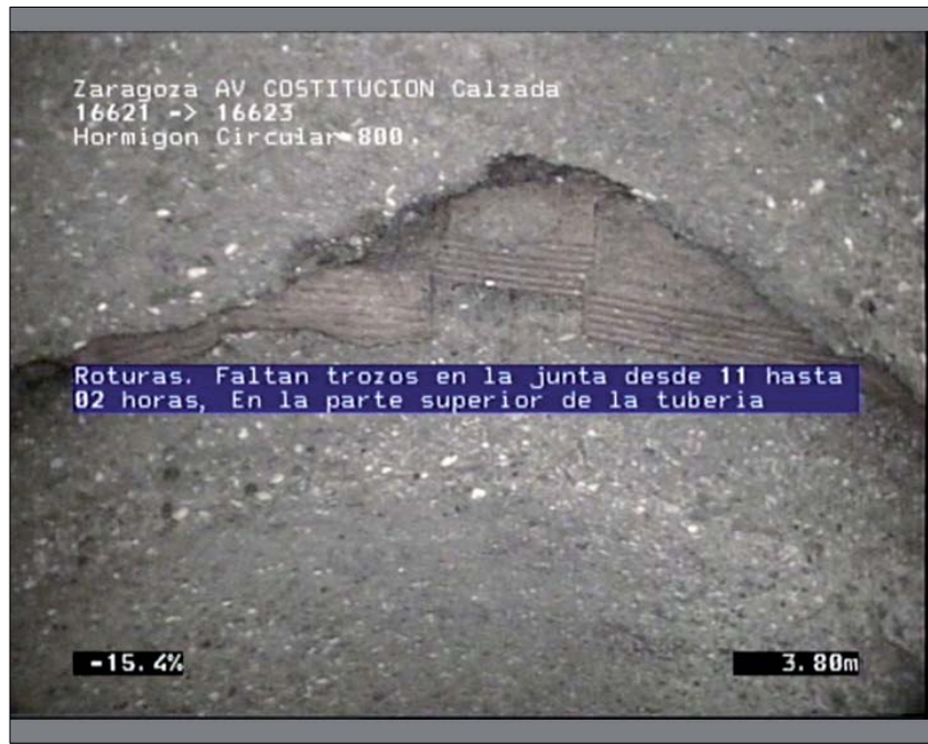
Foto: 5_5_27_A.jpg 3,66m, Roturas. Faltan trozos en la junta desde 11 hasta 02 horas / En la parte superior de la tubería
