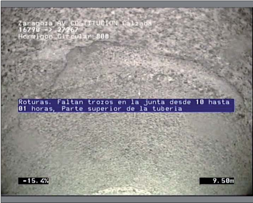
Foto: 1_1_2_A.jpg 9,5m, Roturas. Faltan trozos en la junta desde 10 hasta 01 horas, Parte superior de la tubería
