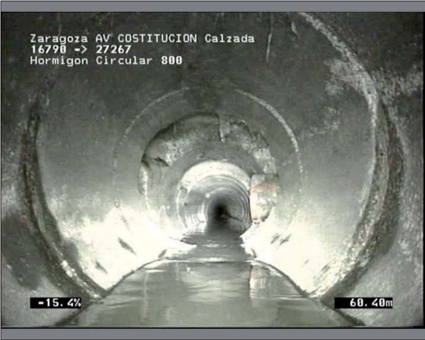
Foto: 1_1_8_A.JPG 60,4m, Comentario / Humedad en la junta de la tubería, parte inferior.
