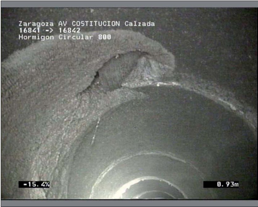
Foto: 11_11_49_A.JPG 1,78m, Roturas. Faltan trozos desde 09 hasta 11 horas / Rotura de tubería o posible acometida anulada.
