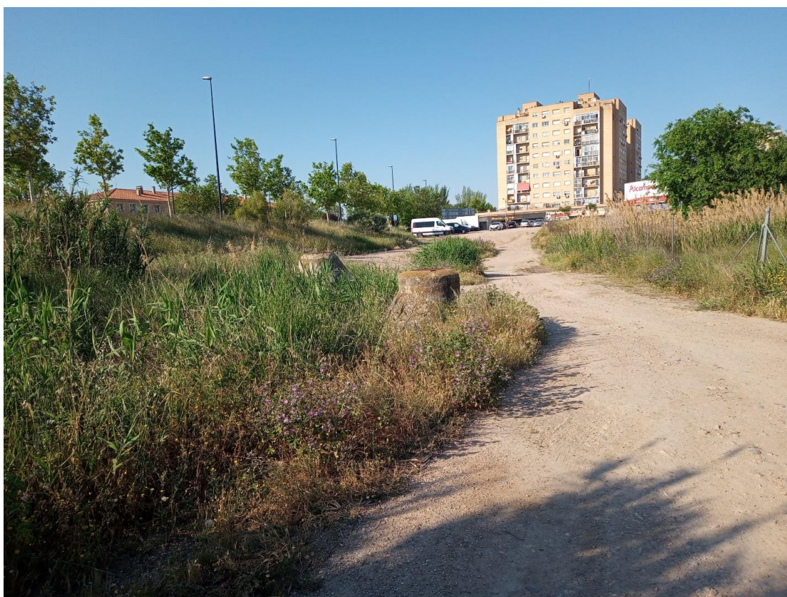
Foto nº 8.- Tramo final de la actuación, desde el arranque en Miguel Servet (al fondo, en la foto).
