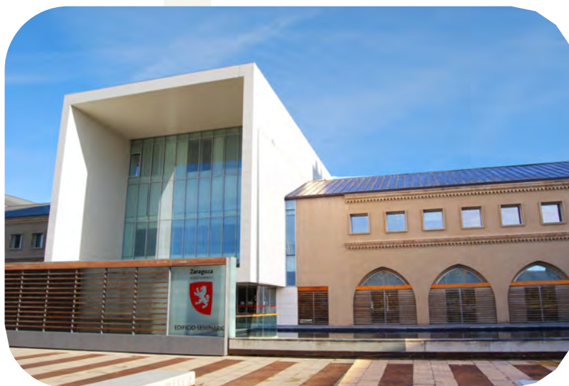
Sede Departamento de Urbanismo, Infraestructuras, Equipamientos y Vivienda. Ayuntamiento de Zaragoza Foto: Sonsles Valero
