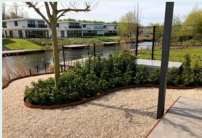
Borde metálico acero corten (150 mm altura 1,5 mm espesor) 25€/ml
