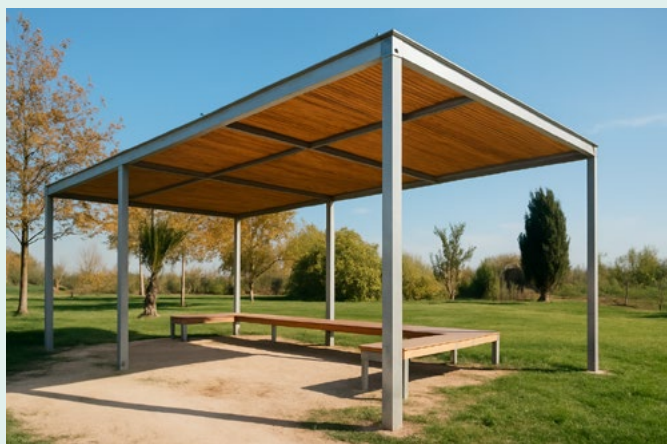
Pérgola metálica y cubierta de madera
